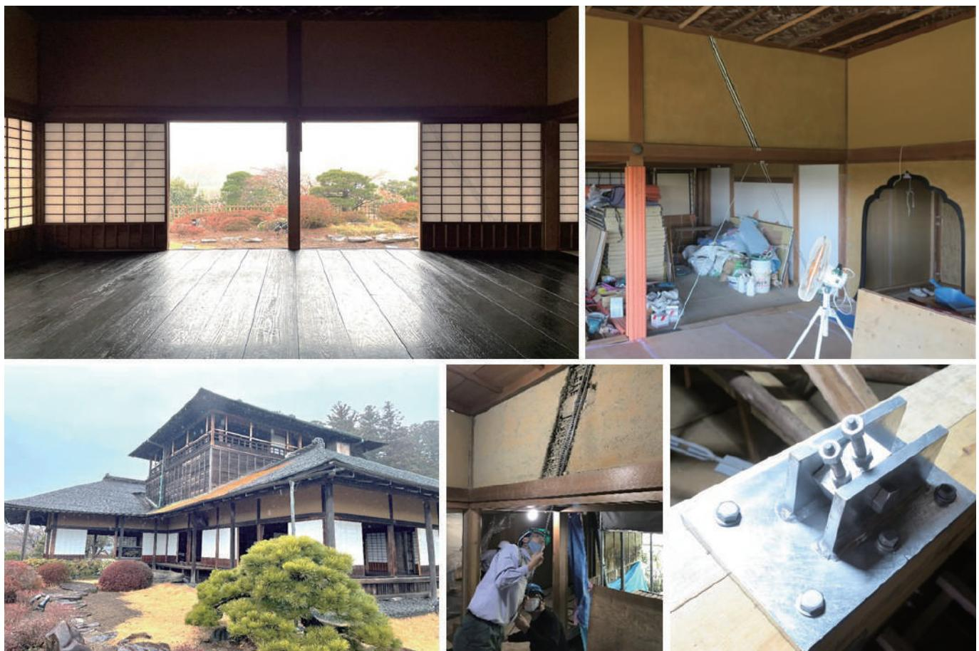
【講評】文化財やそれに類する木造建築物を後世に残して伝えるには、建物の耐震化が必要となる。しかし、日本の伝統的な木造建築はその開放性を大きな特徴としており、壁を増やしたり、筋交を入れたりするといった方法では、本来の空間が備える魅力を大幅に損ねてしまう。この問題を解決するべく、応募者が開発したのが、高張力鋼で製作されたφ7mmの亜鉛めっき鋼線を、2枚の建具に挟まれたわずかな隙間に通して補強するという方法であった。好文亭樂寿樓で実際に施工された状態を写真で見ると、障子を透かして斜めの線が走っているのはわかるものの、その存在感は明らかに希薄化されている。既存建物の解体も最小限で済むことから、広く文化財の建築に普及が期待される技術である。この材料は、もともと長大な斜張橋のケーブルなどで用いられていたものであり、これを真逆な性質を持つ木造建築に活かした点も面白い。（磯）
